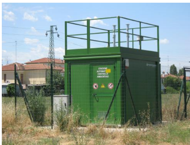
Stazione di Piazza Romagna
